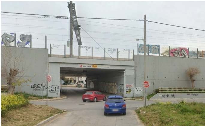
Εικόνα 2 Όψη τεχνικού Λ. Κων/λεως από την οδό Καζαντζάκη (Πηγή: Google Earth)
