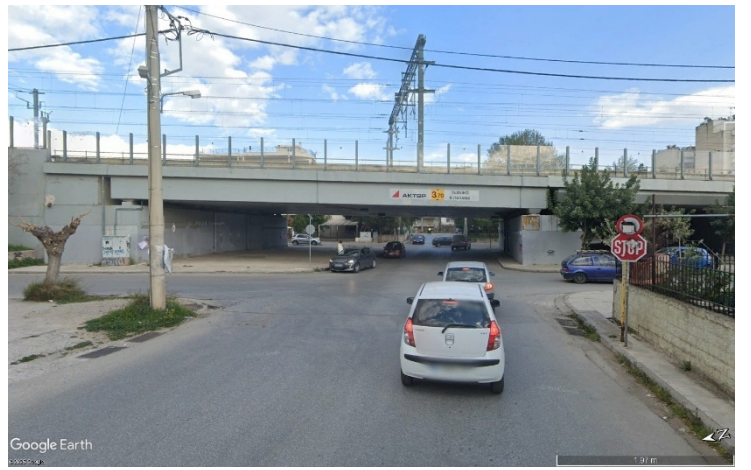
Εικόνα 5 Όψη τεχνικού Λ. Κων/λεως από την οδό Κ. Παλαμά (Πηγή: Google Earth)
