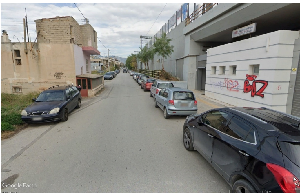
Εικόνα 6 Όψη Λ. Κωνσταντινουπόλεως έμπροσθεν σταθμού «Κάτω Αχαρνάι» (Κλάδος οδού δυτικά του Προαστιακού Σιδηροδρόμου) (Πηγή: Google Earth)
