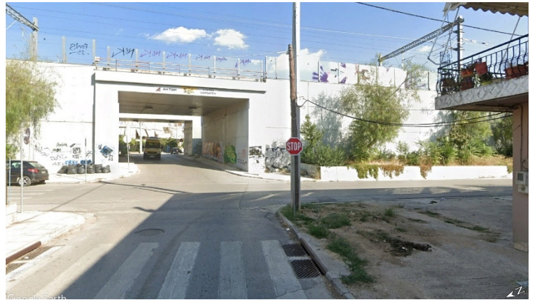
Εικόνα 3 Όψη τεχνικού Λ. Κων/λεως από την οδό Λογοθετίδη (Πηγή: Google Earth)
