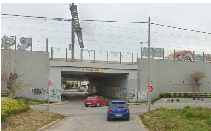
Εικόνα 2 Όψη τεχνικού Λ. Κων/λεως από την οδό Καζαντζάκη (Πηγή: Google Earth)
