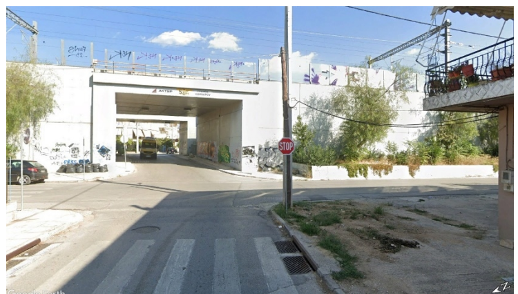
Εικόνα 3 Όψη τεχνικού Λ. Κων/λεως από την οδό Λογοθετίδη (Πηγή: Google Earth)
