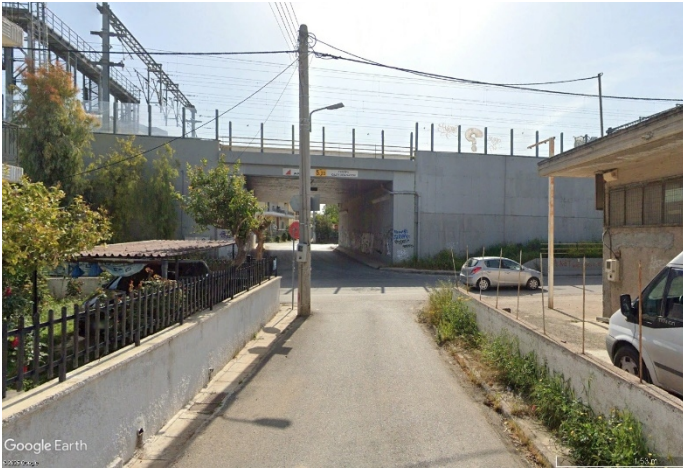
Εικόνα 4 Όψη τεχνικού Λ. Κων/λεως από την οδό Αισώπου (Πηγή: Google Earth)
