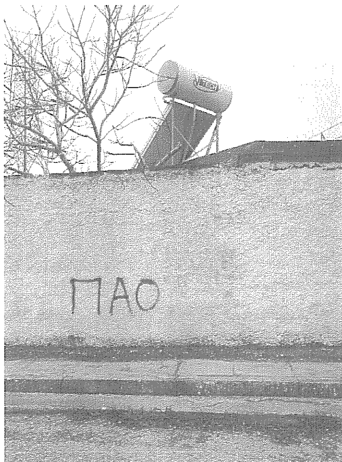
Εικόνα 2. Τμήμα προς ανάπλαση της οδού Κ. Καραμανλή – κτίριο εκτός εγκεκριμένης ρυμοτομικής γραμμής.
