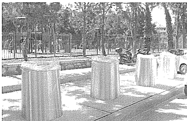
Εικόνα 21. Υπόγειοι κάδοι απορριμμάτων συμπίεσης
